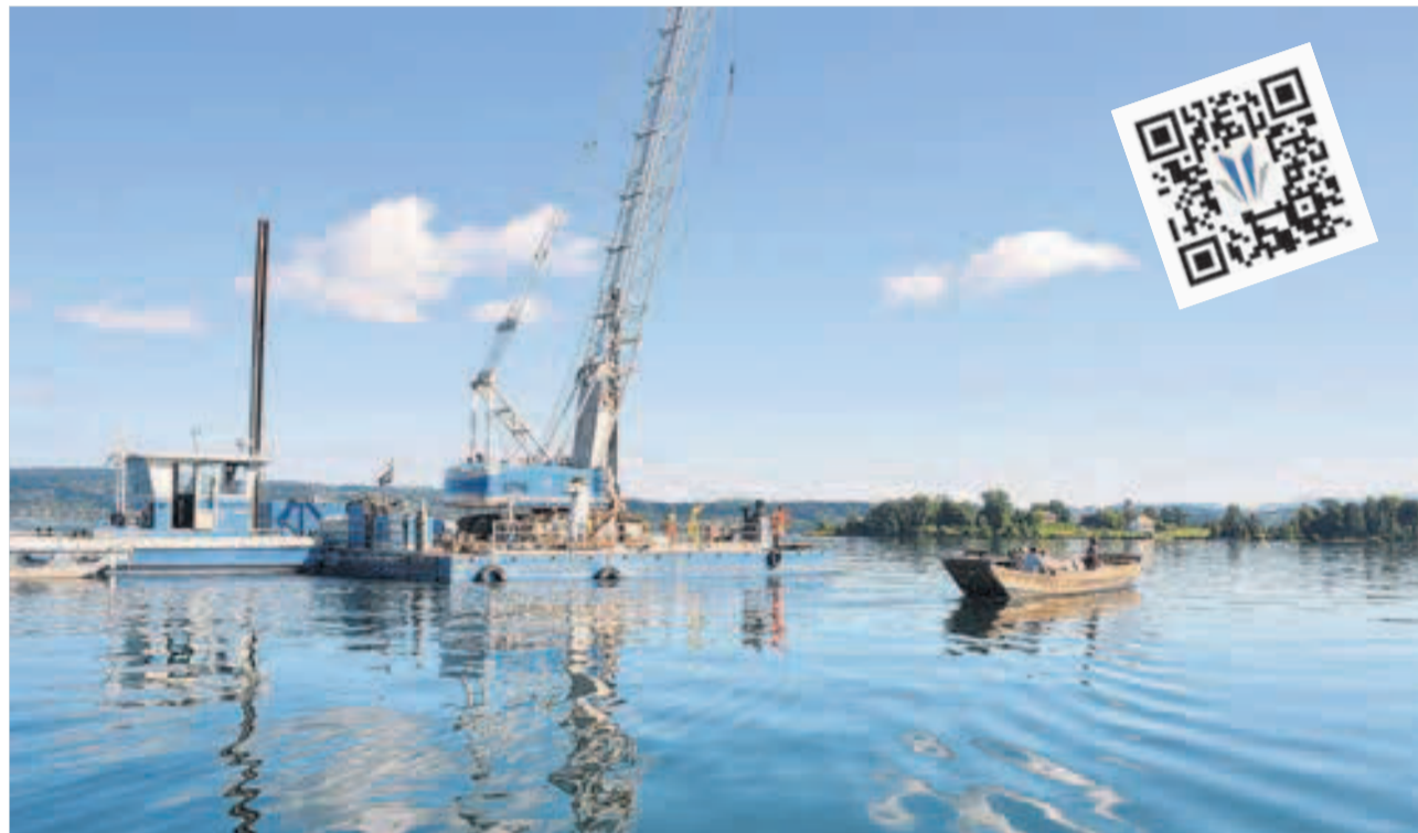
Der Ponton und die Pfaffenschunke gleiten langsam der Ufnau zu.
