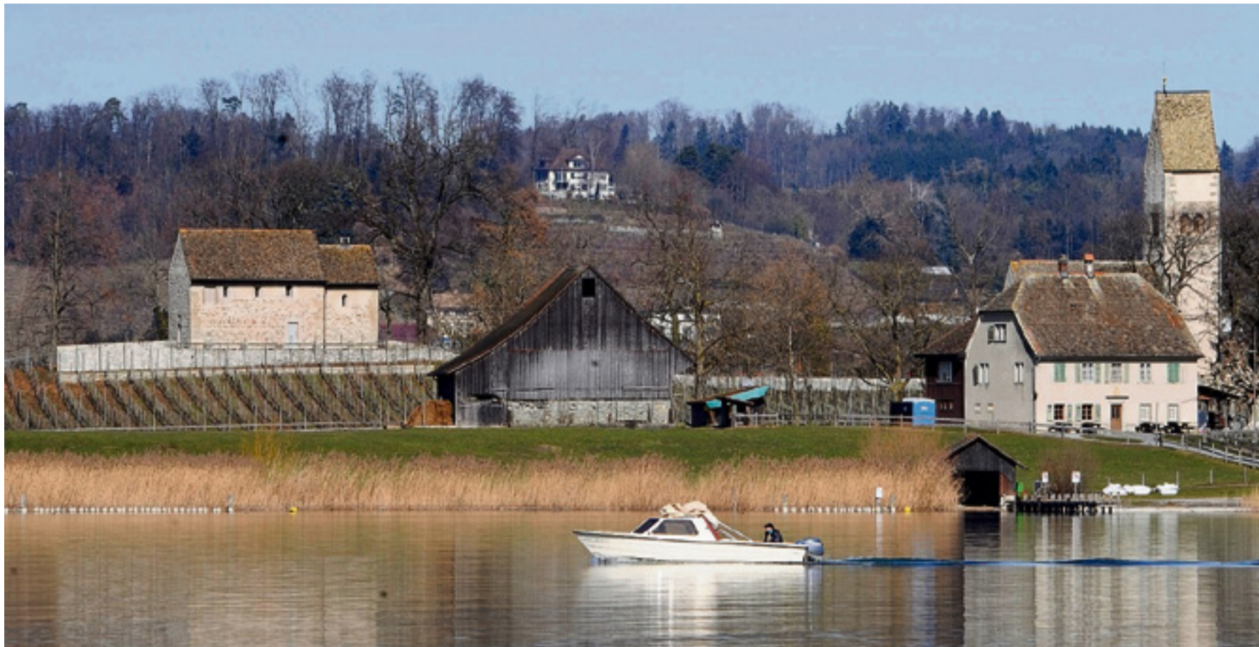
Das Gasthaus (rechts) ist baufällig und marode. Dennoch darf es weder abgerissen noch ersetzt werden. Das Pächterpaar bedauert dies zutiefst. Bild: Kurt Heuberger
