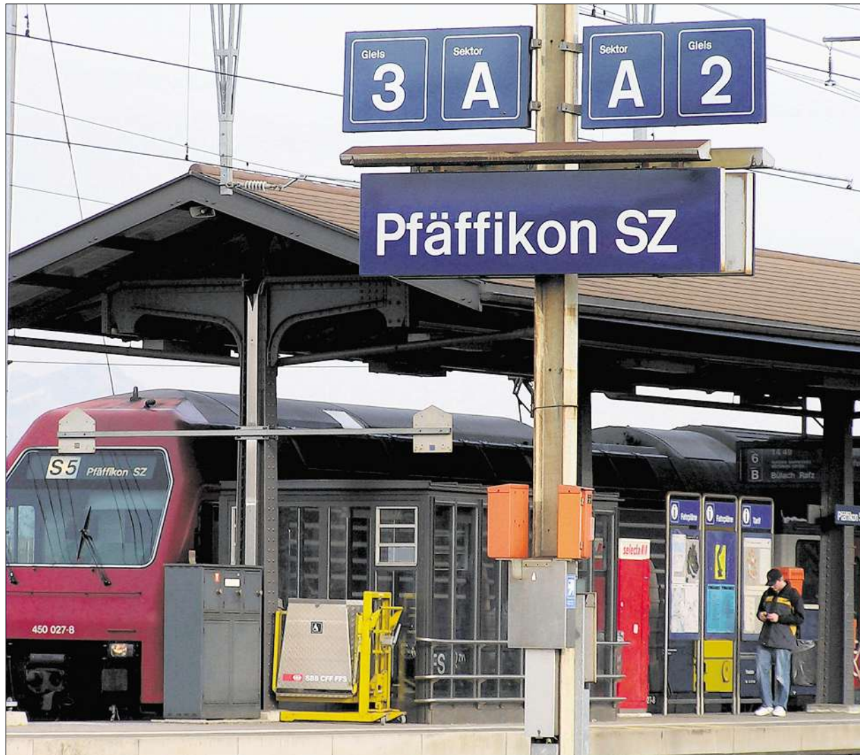
Für das Projekt Stadtbahn Obersee ist der Bahnhof Pfäffikon ein wichtiger Knotenpunkt. (spa)
